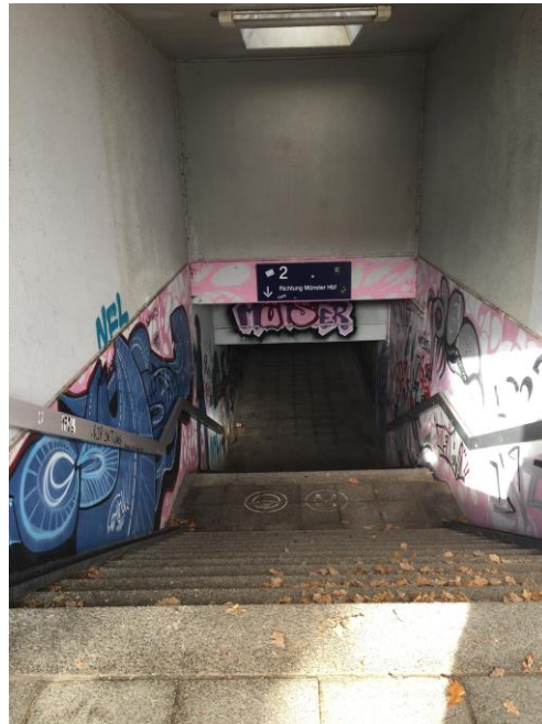
Unterführung Bahnhof Ostbevern
