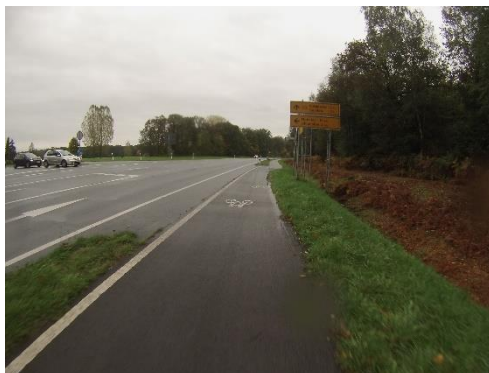
Abb. 3.6-7 Gemeinsamer Geh- und Radweg, B-235 Senden (künftig Veloroute nach Münster Abzweig K-60) (eigene Aufnahme)
