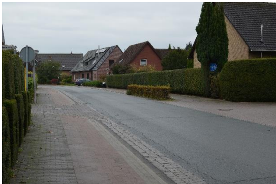
Abb. 3.5-3 Beidseitiger getrennter Geh- und Radweg, Venner Straße Ottmarsbocholt (eigene Aufnahme)
