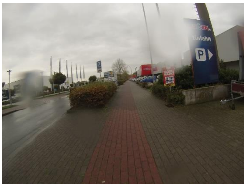
Abb. 3.6-6 zu schmaler getrennter Geh- und Radweg, Bahnhofstraße Bösensell (eigene Aufnahme)
