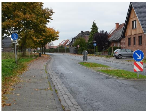
Abb. 3.6-9 Wechsel Führungsform außerorts-innerorts mit zu kleiner Mittelinsel und Fortführung zu schmaler getrennter Geh- und Radweg, Venner Straße Ottmarsbocholt (eigene Aufnahme)
