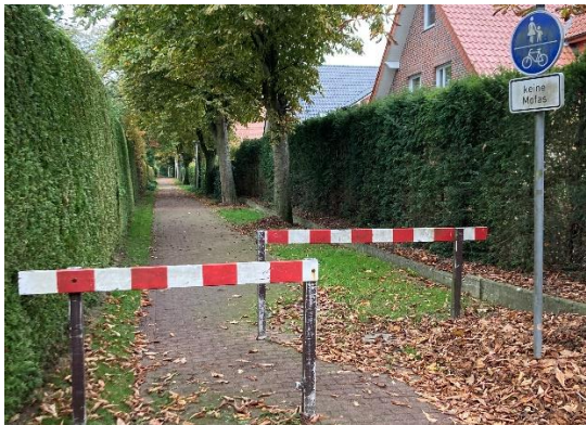
Abb. 3.6-4 Symbolbild Umlaufgitter, Appelhülsener Straße Höhe Haltestelle Erlengrund Senden (eigene Aufnahme)
